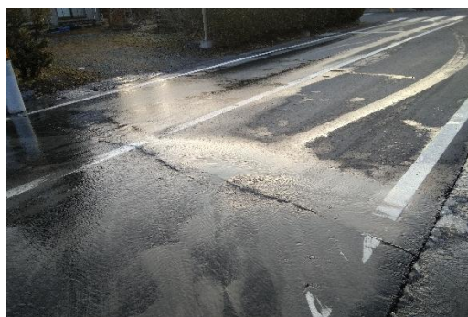
図表 10 地震による漏水被害
