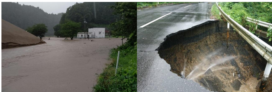
図表 11 浸水する米谷浄水場と道路陥没による漏水
